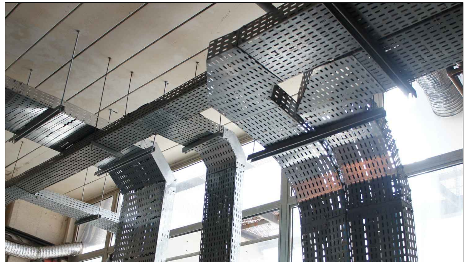
Modelo de instalação eletrocalha
