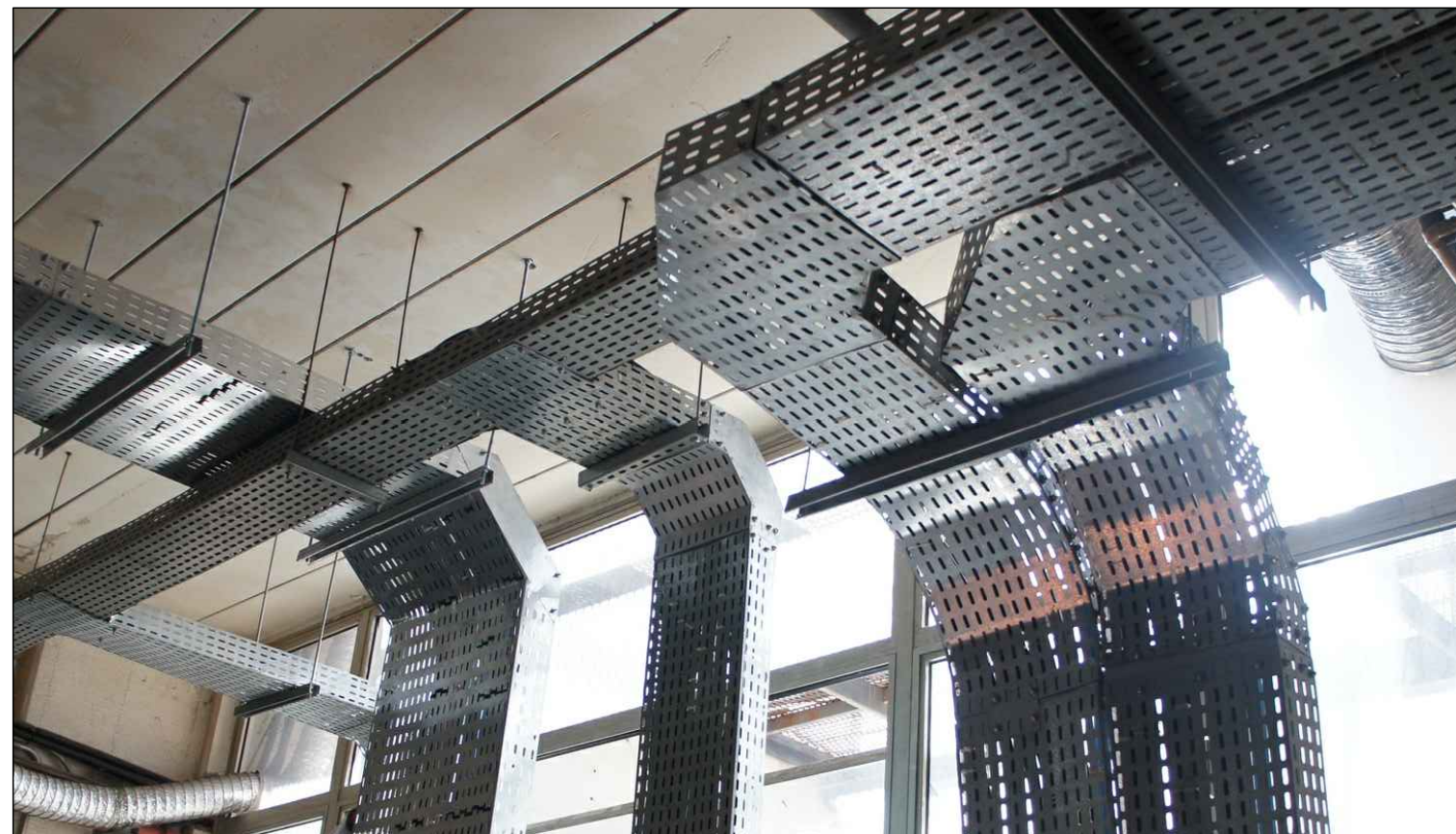
Modelo de instalação eletrocalha
